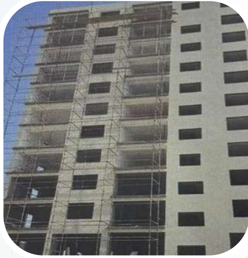
بناية وقف مدرسة الخيرات لتحفيظ القران (المعيلة) تركيب نظام إنذار الحرائق الجديد ونظام مكافحة الحرائق وتوصيلات غاز البترول المسال
