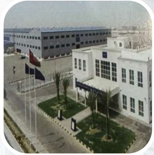
مصنع الخليج الدولي لصناعة الأنابيب صيانة نظام مكافحة الحرائق ومطفآت الحريق
